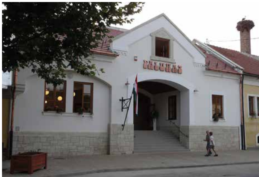
▲ Faluház újjáépítése, Bodrogkeresztúr. Tervezőtárs: Erhardt Gábor, 2008
